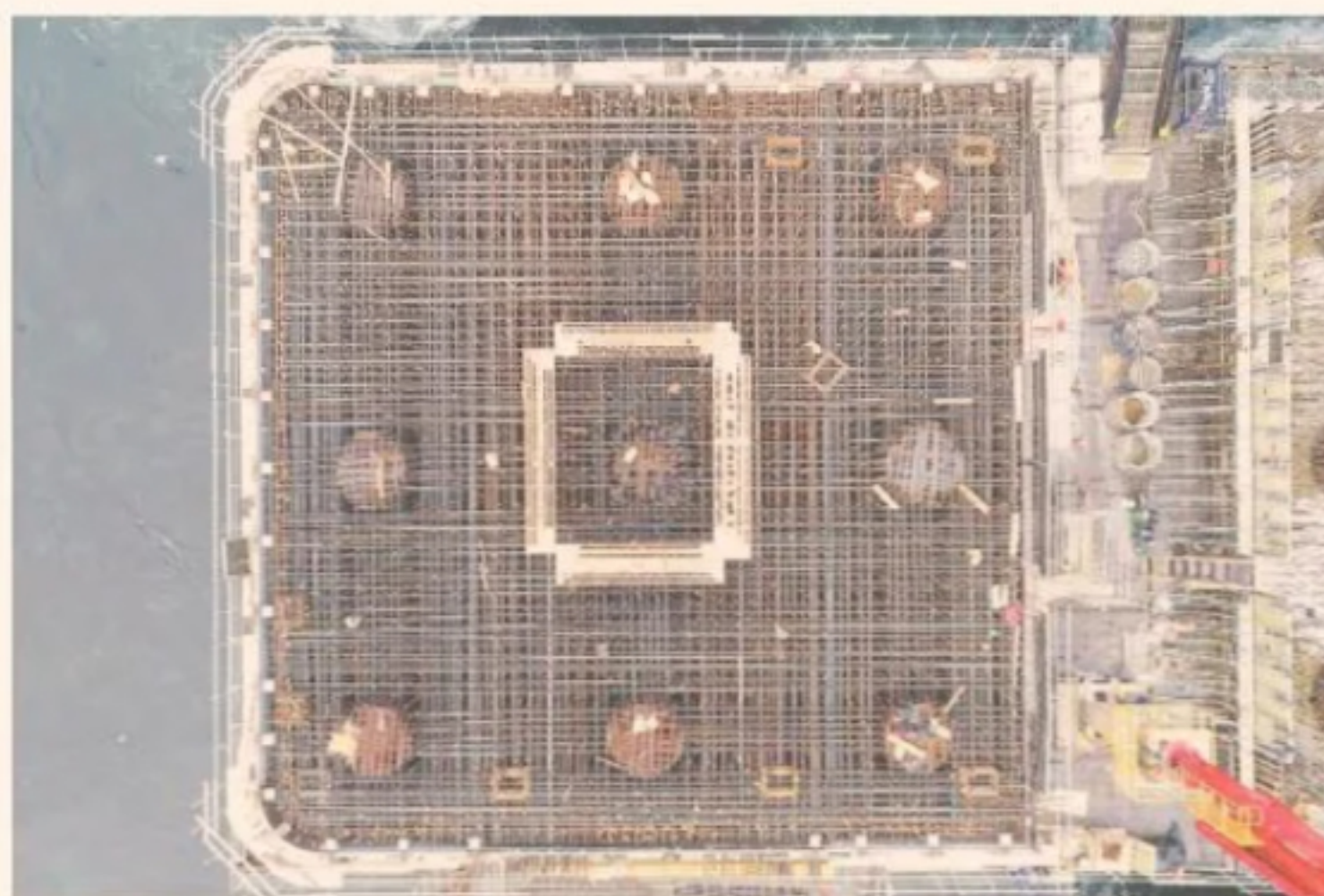
Los aceros de alta resistencia de Compañía Siderúrgica Huachipato están siendo utilizados en emblemáticas construcciones de infraestructura. En la imagen, vista aérea de las obras en Puente Chacao.
