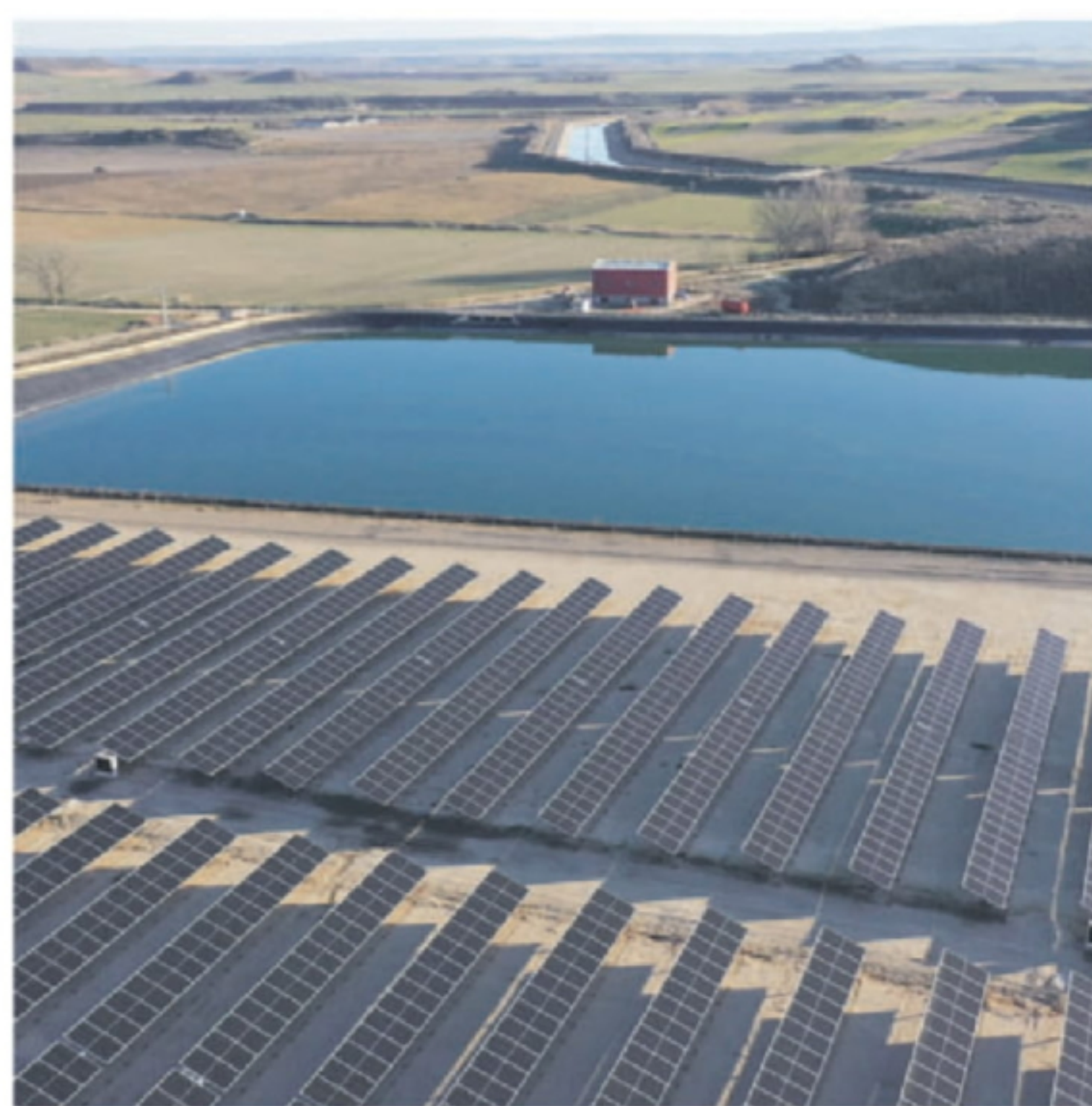
En Montesús, España, ACCIONA Energía ha instalado el mayor sistema de riego en el mundo alimentado por una planta solar sin baterías. Foto: Acciona.
