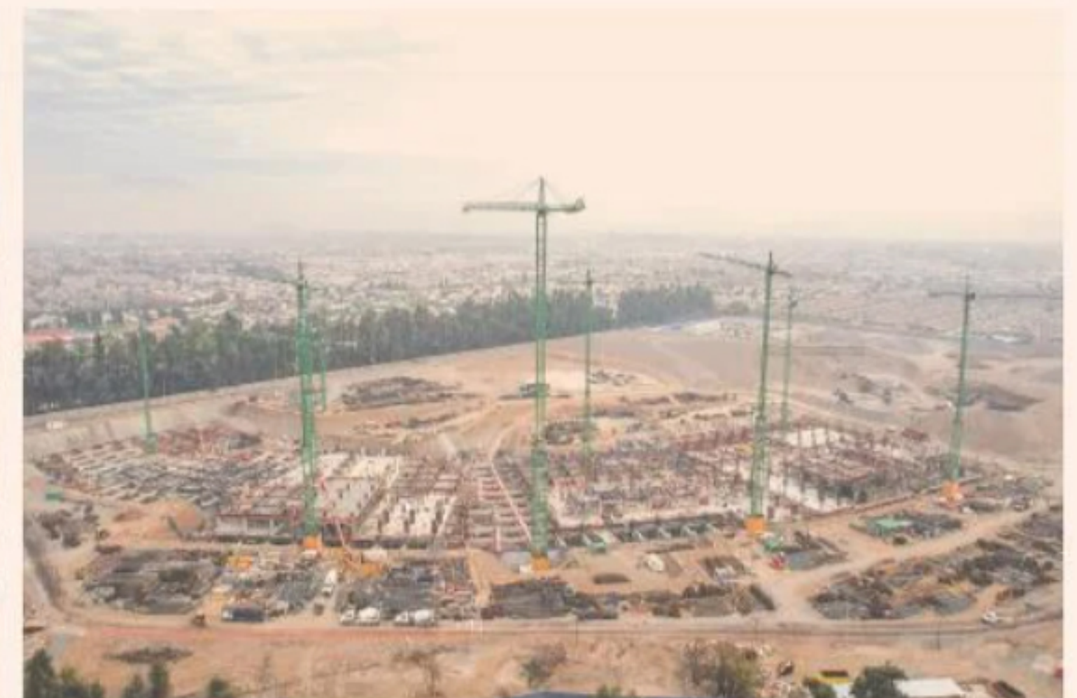
El nuevo Hospital Sótero del Río se encuentra en etapa de construcción.
